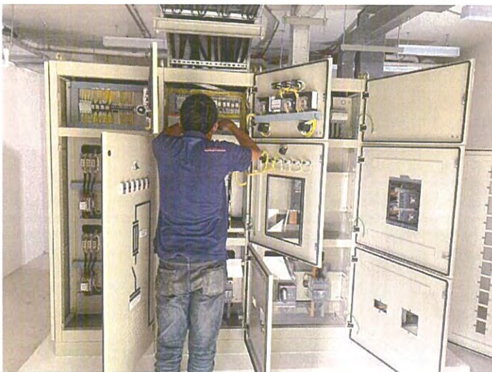
ตรวจเช็คและทำความสะอาดตู้ MDB
